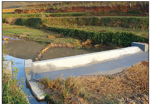
Masonry diversion cum check dam
