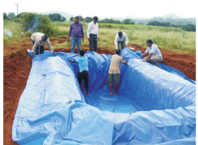
जल संरक्षण हेतु सिलपोलिन तालाब की निर्माण प्रक्रिया
